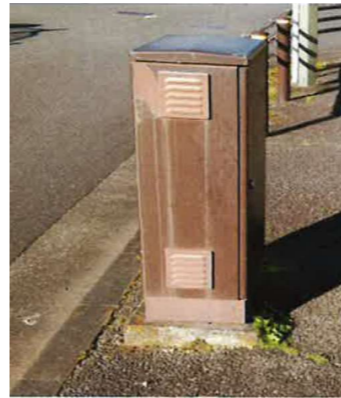
歩道(アスファルト舗装)
